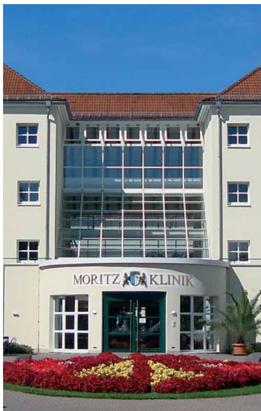
Moritz-Rehabilitationsklinik, Bad Klosterlausnitz
