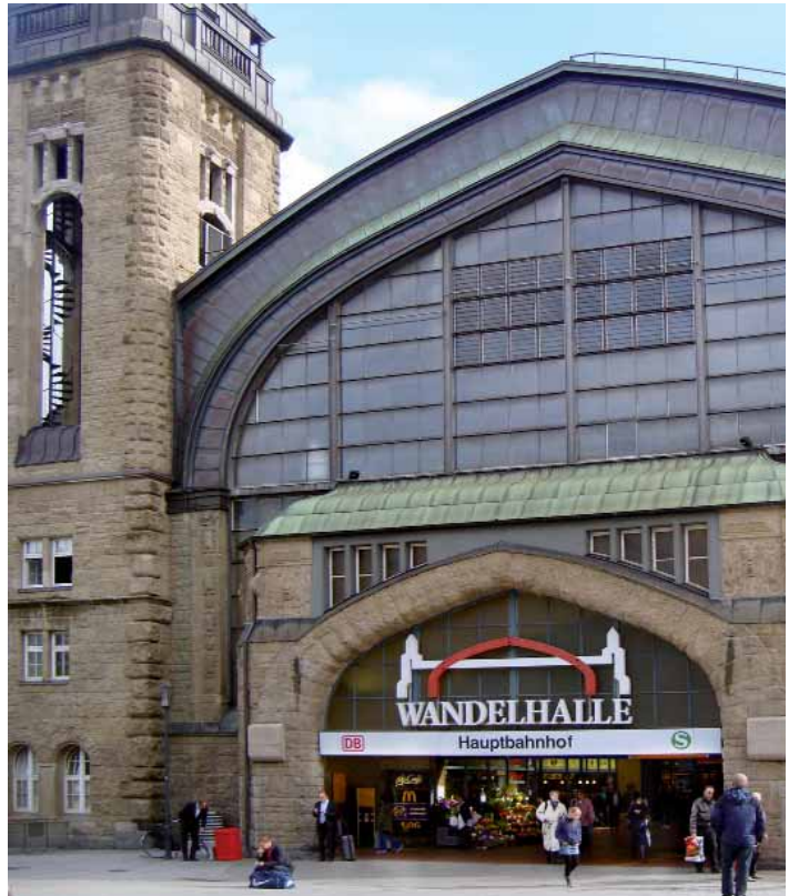
Wandelhalle Hauptbahnhof, Hamburg
