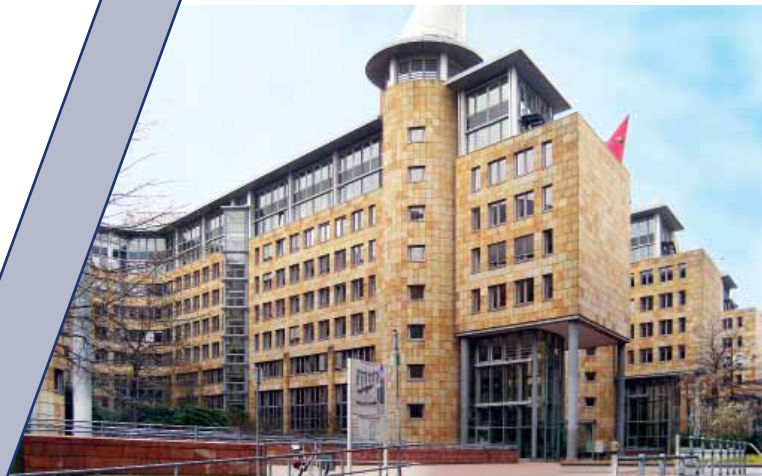
„Finanzamt“, Frankfurt/Main (Teilinvestition des Dachfonds)
